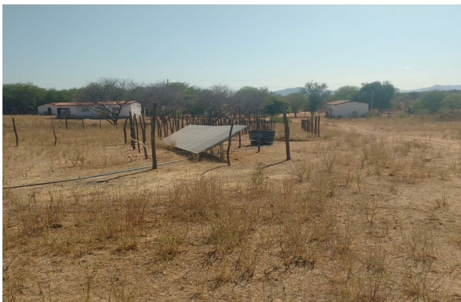
Placas fotovoltaicas no assentamento Nossa Senhora de Aparecida, municipio de São Mamede.
