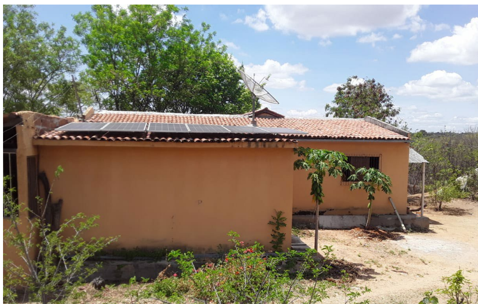
Placas fotovoltaicas no Centro de Capacitação Agro-Comunitário (CCA), município de Princesa Isabel.
