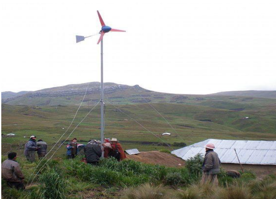
Imagen: Instalación de generador eólico en la comunidad rural El Alumbre.
