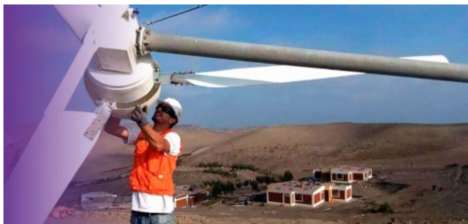
Imagen: Instalación de generador eólico en casa escuela Tarpuy.
